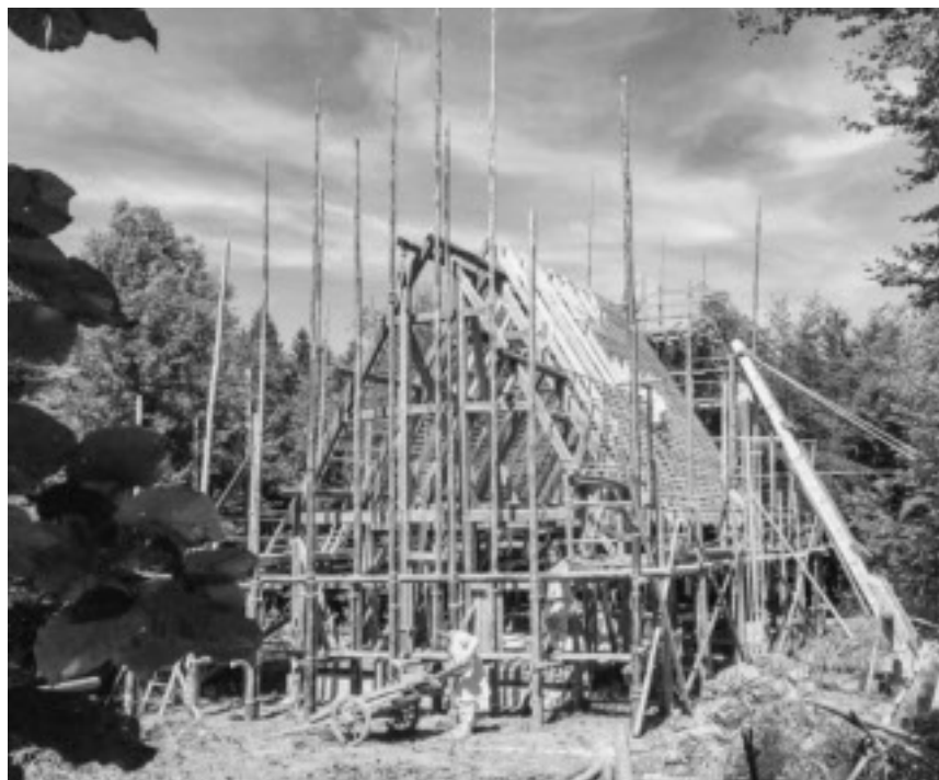
Die Holzkirche entsteht mit Handarbeit und altertümlichen Werkzeugen.
